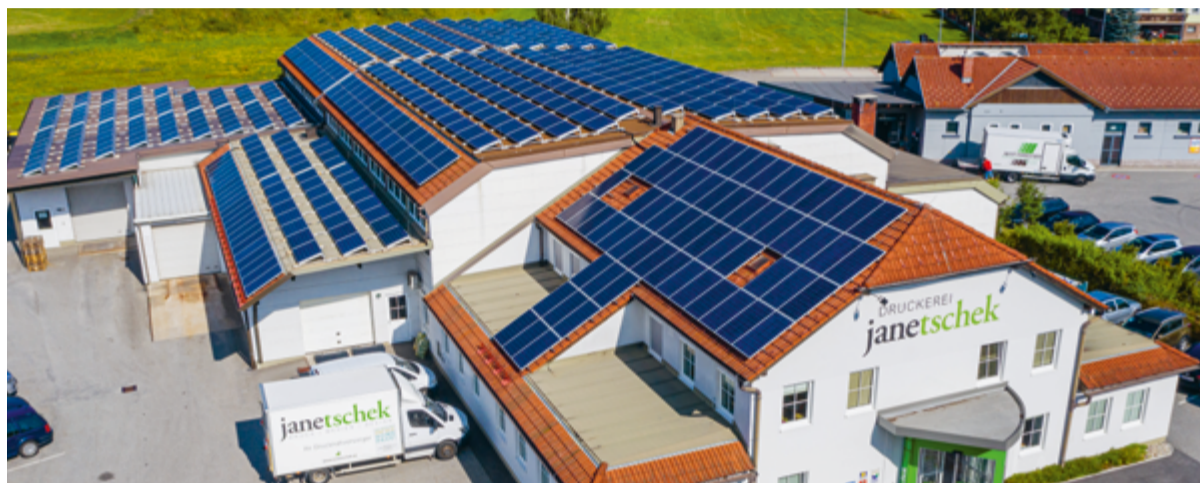
Leistungsstarke Photovoltaikanlage auf den Dächern der Produktionsstätte. Durch Rückkauf der Energie kann das Unternehmen etwa 1/3 seines Energiebedarfs decken.
